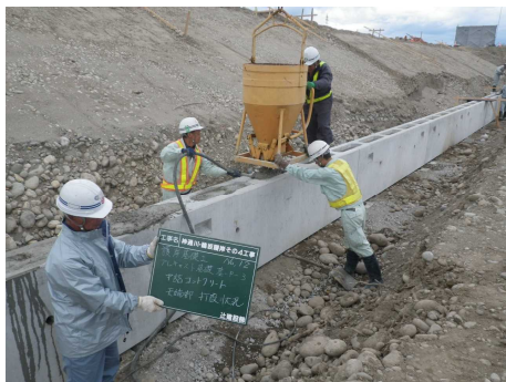
写真 2. 4 中詰材充填
