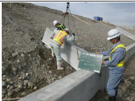
写真 2. 5 隔壁工の設置
