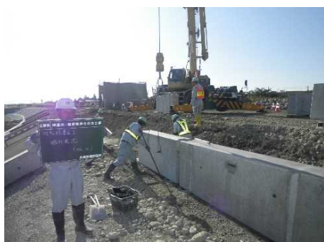
写真 2. 6 巻止工の設置
