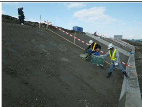
写真 2. 8 裏込材投入・締固め
