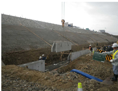
写真 2. 3 基礎工の設置
