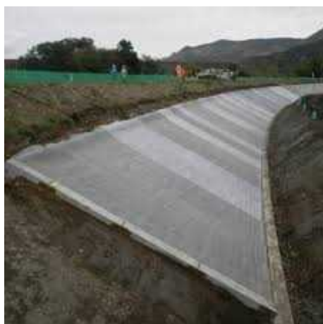
写真 2. 7 遮水シート設置
