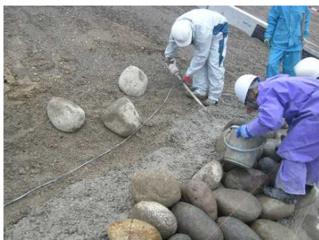
写真 2. 9 玉石配置(1) (裏込コンクリート打設・養生)
