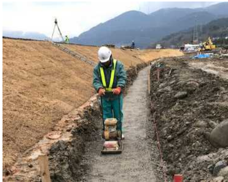
写真 2. 2 基礎碎石の設置
