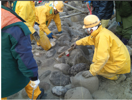
写真 2. 12 補助器具（バカ棒）による 胴込コンクリート厚の調整
