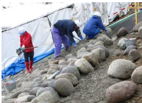
写真 2. 11 胴込コンクリート打設
