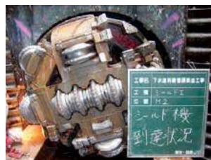
シールド機の到達状況
