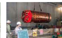
シールド機吊降ろし状況
