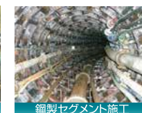
鋼製セグメント施工
