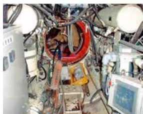
シールド機内の様子
